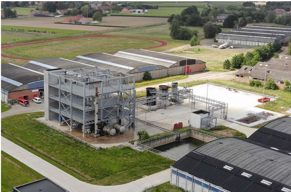
Het industrieel oefencomplex met links de drie verdiepingen hoge proceseenheid, daarnaast het tankpark met de leidingenbrug, uiterst rechts de leidingengracht met loopbrug en vooraan het bufferbekken voor de waterzuivering. Copyright: Campus Vesta
